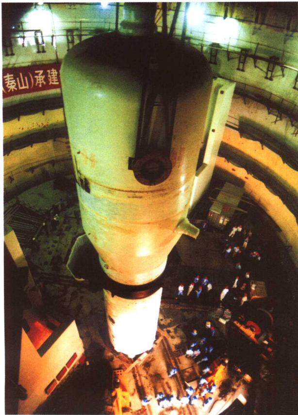
吊装蒸汽发生器
