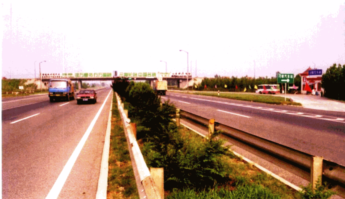
济青高速公路刁镇立交桥
