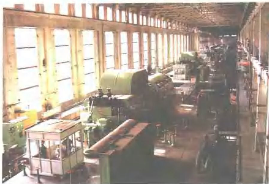
9 阜新电厂内景
