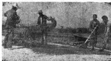
圖5 人工修築路面
