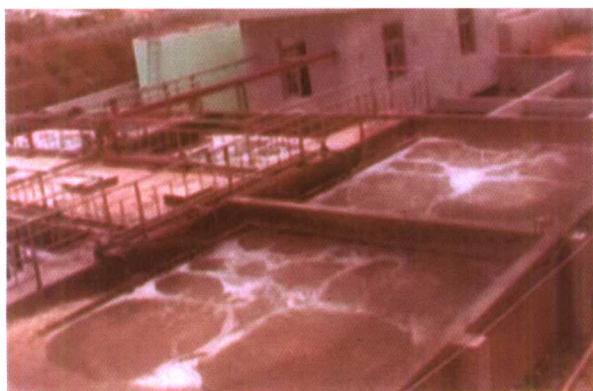
福建龙威食品有限公司废水处理工程 日处理量 400\text{m}^3/\text{d}
