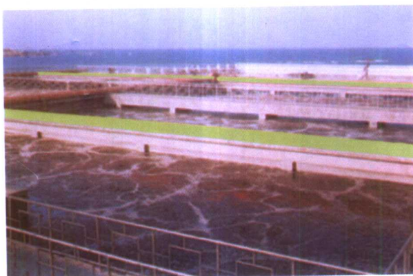
漂染废水处理站 日处理量 5000\text{m}^3/\text{d}
