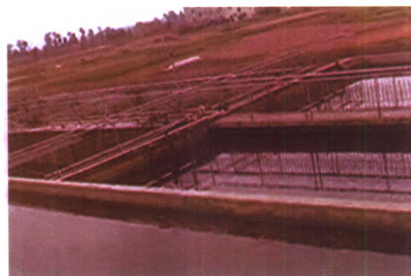
福建麒麟啤酒有限公司废水处理工程 日处理量 2500\text{m}^3/\text{d}
