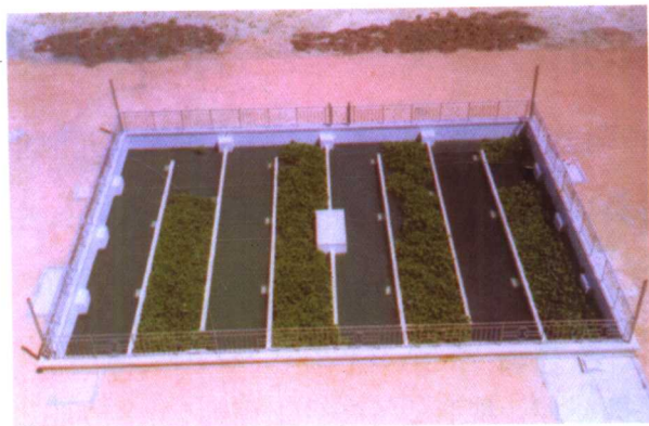
冠捷电子（福建）有限公司生活污水处理 两期工程总处理量 1100\text{m}^3/\text{d}
