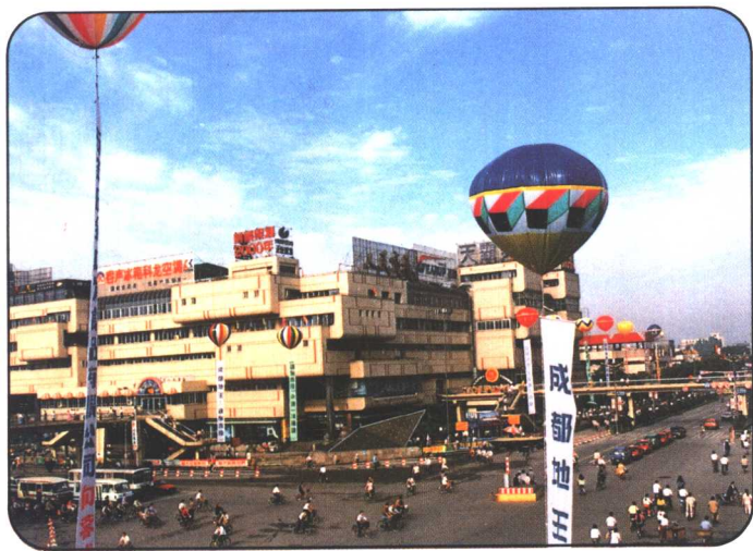
△宏伟的人民商场大楼
