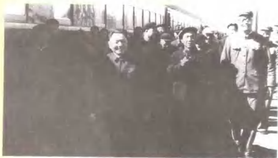
1965年11月。中共中央总书记邓小平(中)与国务院副总理李富春(右二)视察西南铁路建设工地。
