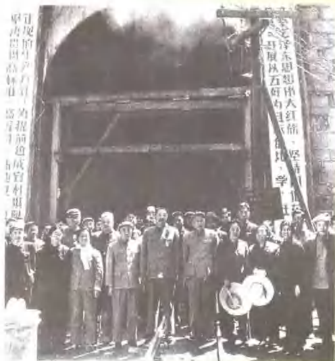
1966年春，国务院副总理贺龙(前排左五)，西南局第一书记李井泉(前排左六)视察正在施工的成昆铁路官村坝隧道。
