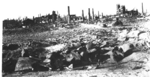
鸭绿江畔的新义州到处是残垣断壁。
