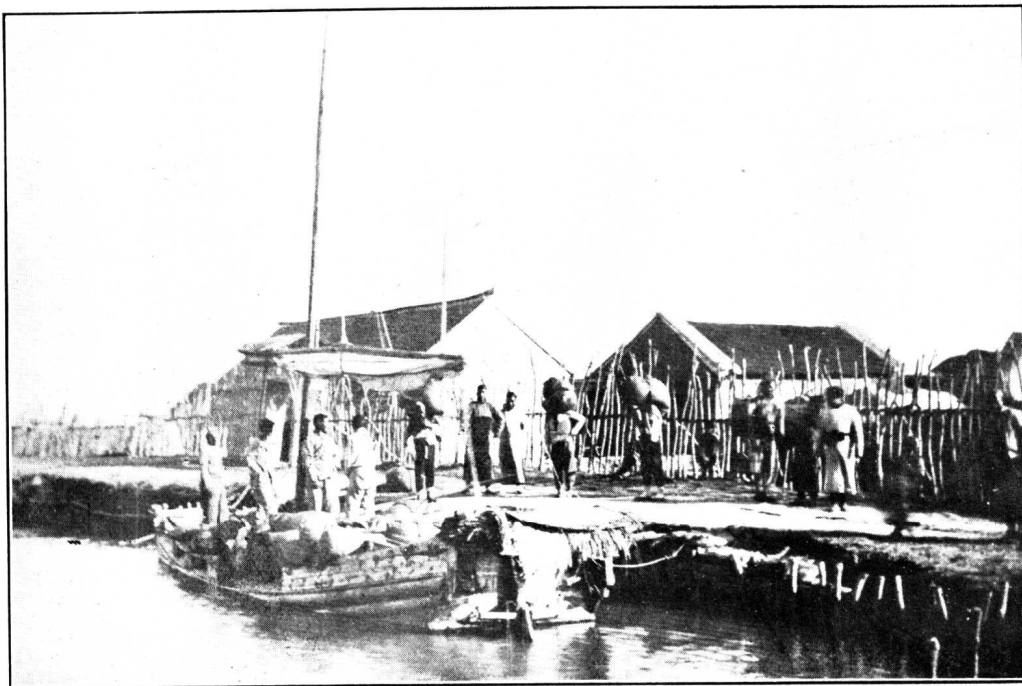
濟南大德公司西二圩駁鹽過橋圖
