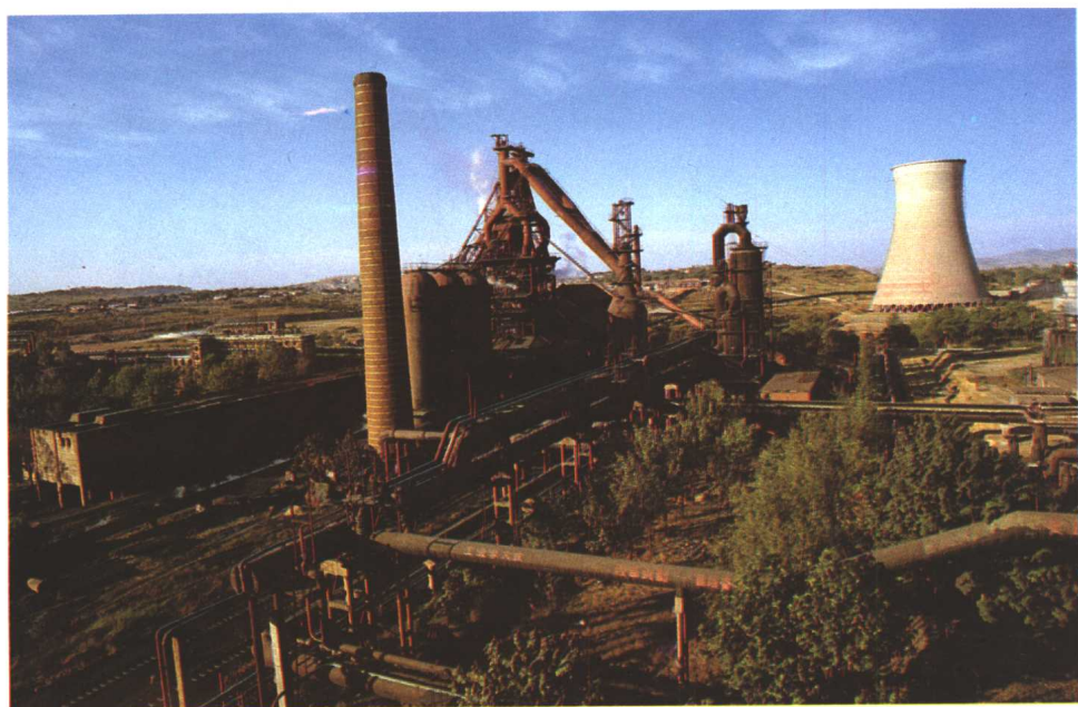
莱芜钢铁总厂第二铁厂
