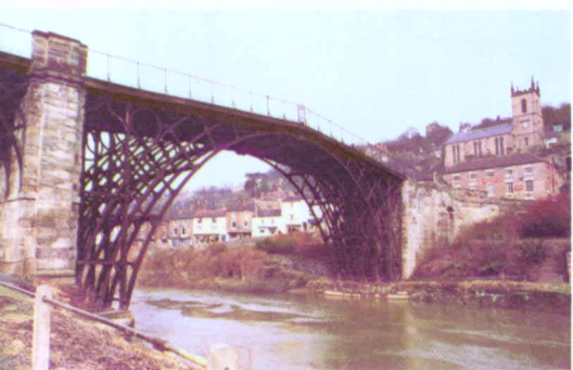
左：橫跨塞汶河上的世界第一座鐵橋，至今仍壯觀如昔 右：煤坑裡的捲揚機（布利茲崗戶外博物館）
