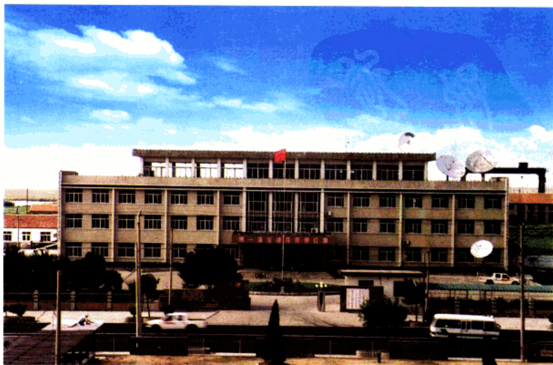
羊口镇党委、政府办公大楼
