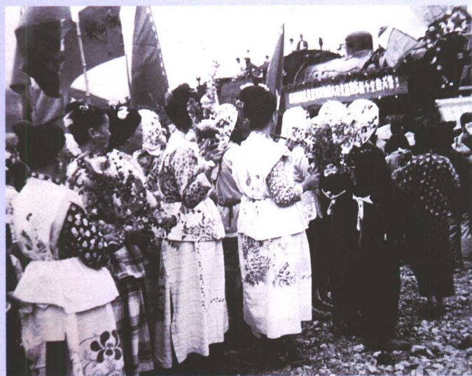
1955年8月担负黔桂线都匀至金城江段复轨施工，1957年10月竣工通车。
