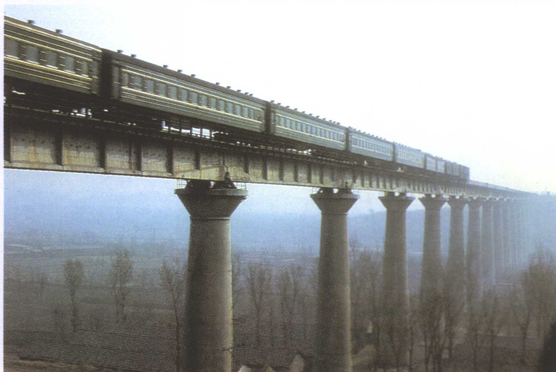
京原线最高桥——大石河特大桥，最高墩 34.4 米，全长 515.22 米。
