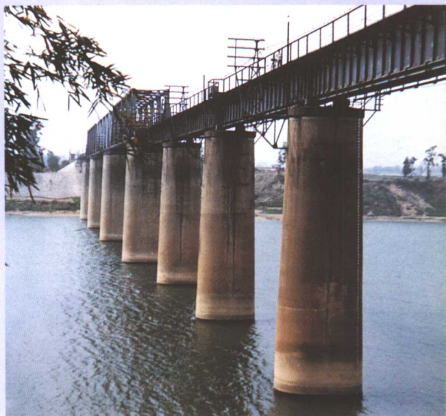
1957年7月抢建竣工的湘桂线邕江大桥。
