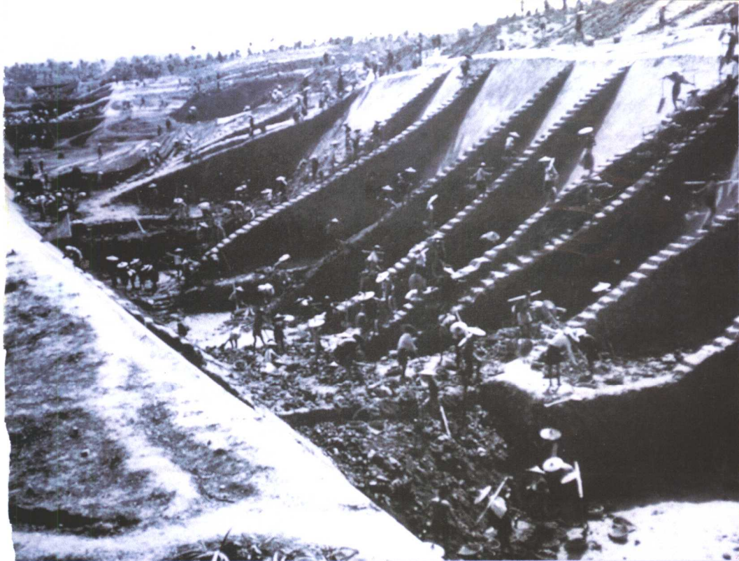
黎湛线建筑工地（1954年）
