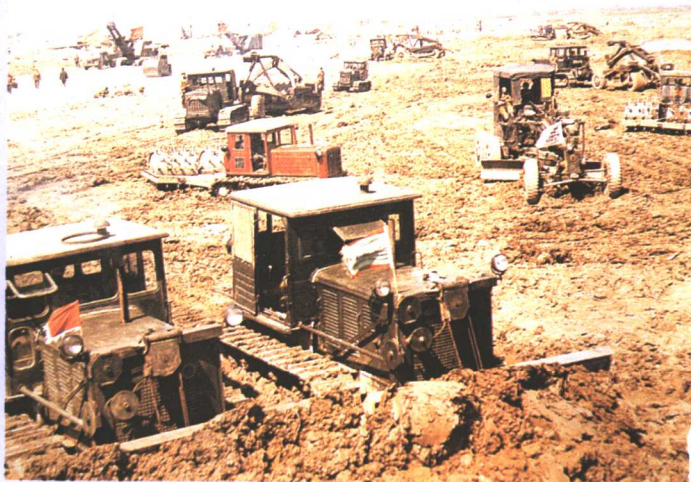
上海虹桥机场扩建土方施工(1964年)
