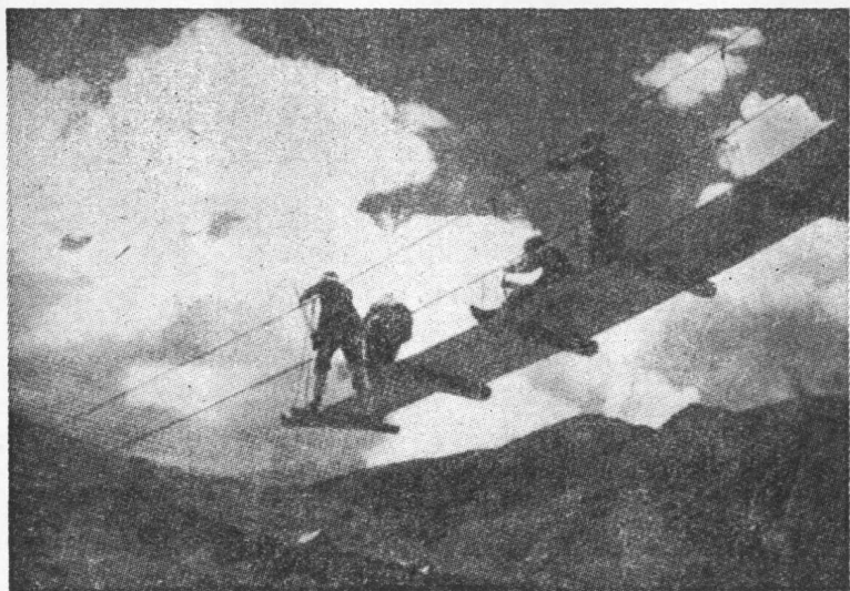
在修建怒江吊索橋工程中，築路者正從空中把吊橋向對岸伸展。
