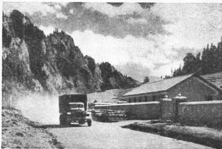
康藏公路經過的偏僻的山區，已開始改變了舊日的面貌。在荒涼的山坡上已蓋起了新的房屋。
