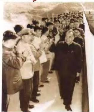
1958年春，朱德委员长视察佛子岭水库
