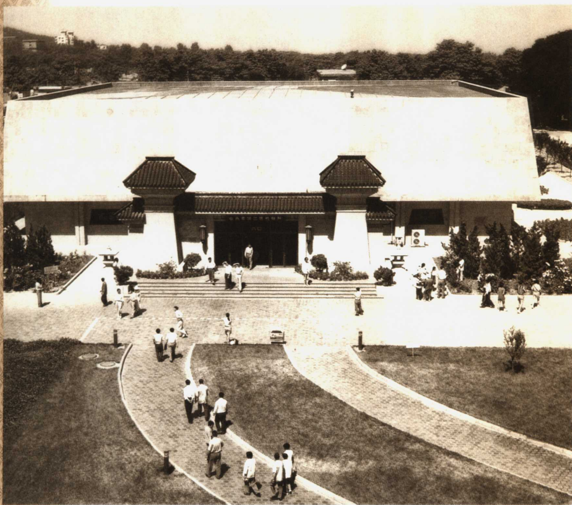
三号坑遗址大厅外景
