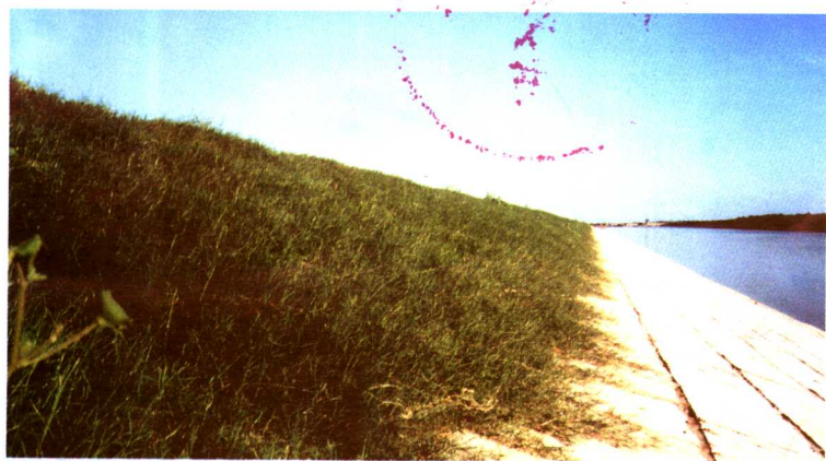
河道护坡草坪
