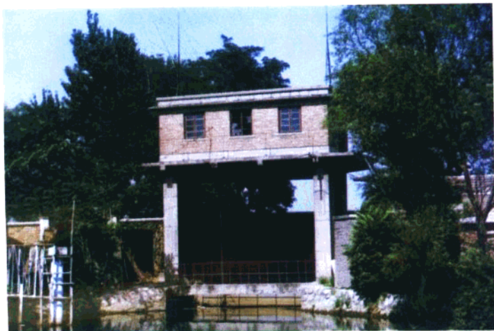
◀ 滏阳河上马头节制闸
