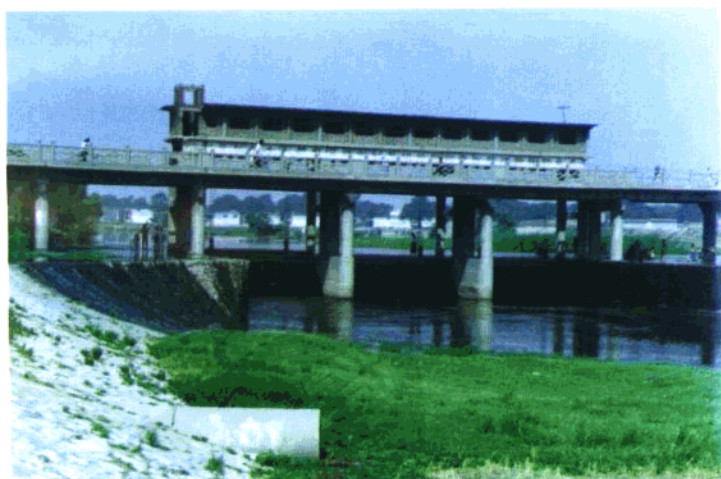
◀ 支漳河张庄桥分洪闸
