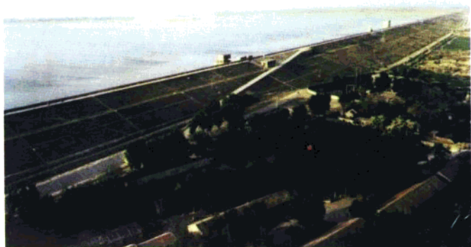
▶ 灌区供水主要工程之一——东武仕水库
