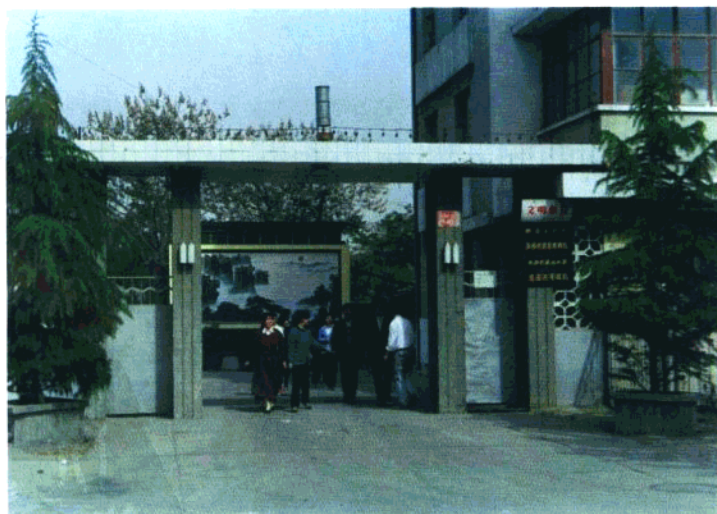
▶ 漳滏河灌溉供水管理处办公大楼
