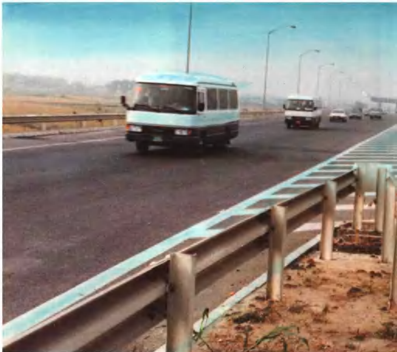
济(南)青(岛)高速公路第一合同段是国际标准的双向四车道,设计时速100公里,全宽26米,设有中央分隔带、防撞钢护栏、显明的夜间反光标志、道路标线和隔离栅。实行全封闭、全立交、分道行驶,并实行收费。该段公路的开通,结束了山东省没有高速公路的历史。
