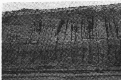
(3) 淺海沉積階地因修築公路所引起的細溝侵蝕 (湛江市附近)
