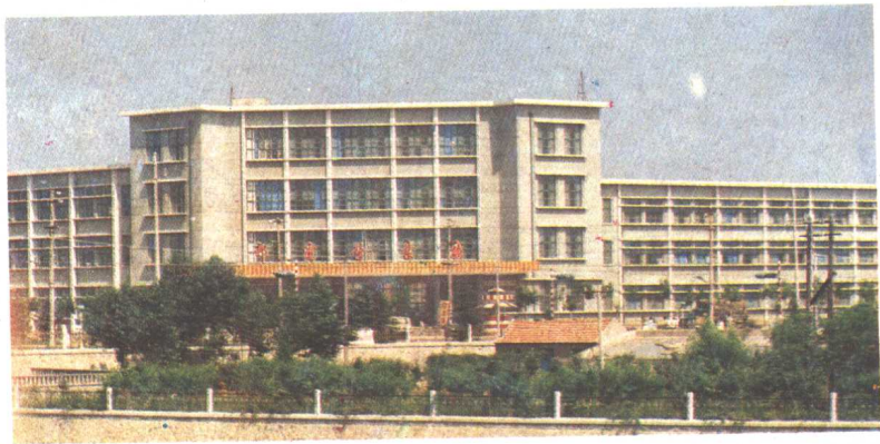
即墨邮电大楼
