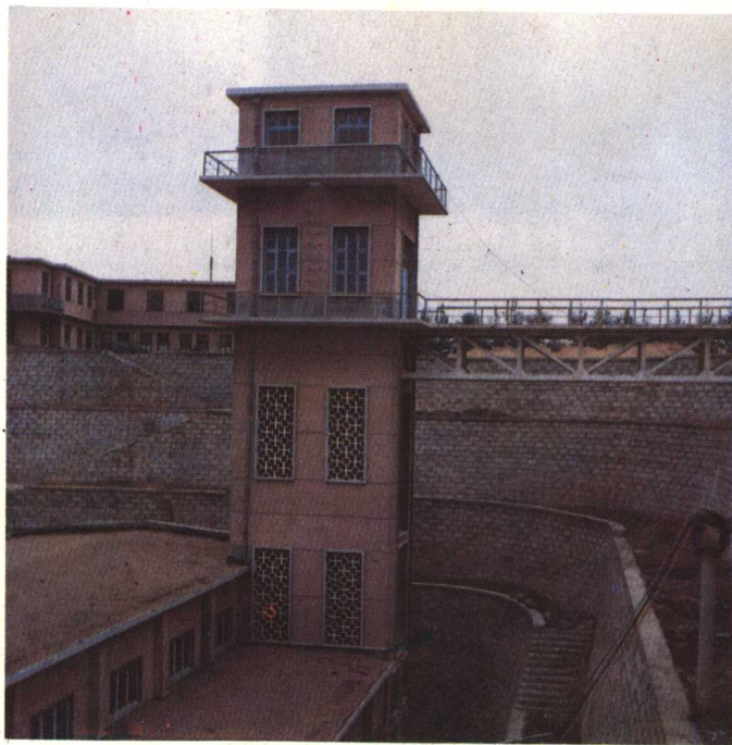
“西水东调”枢纽
