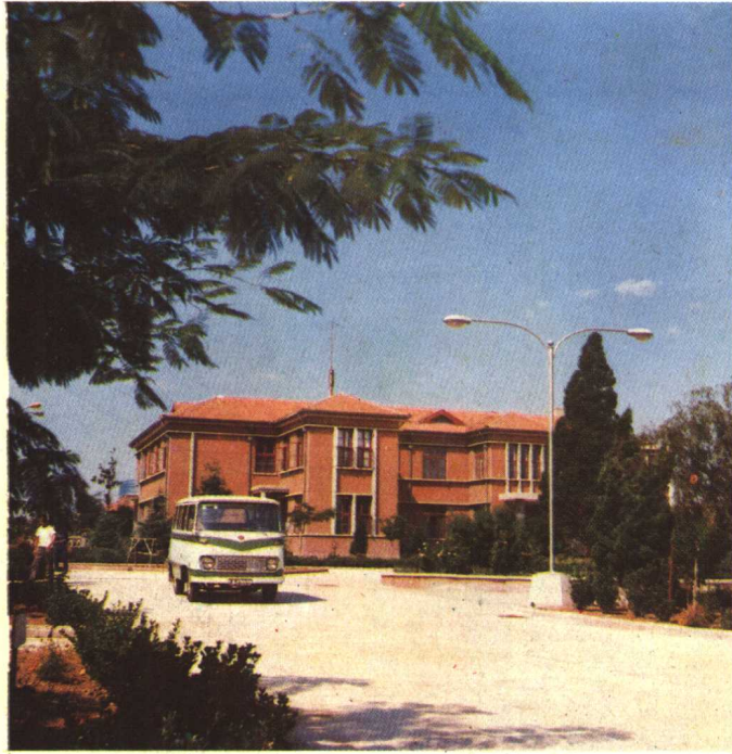
中共即墨县委办公楼
