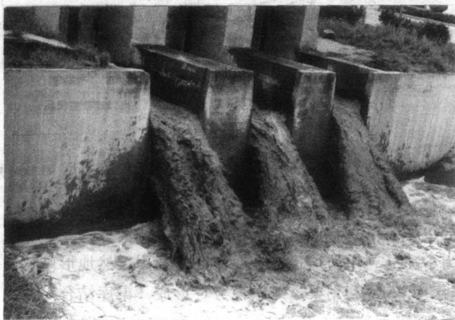
图 1-3 陕西省渭惠渠干渠十号跌水现状照片
