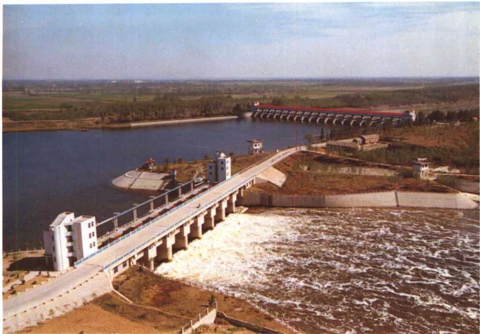
沂沭河洪水东调控制工程之一——大官庄水利枢纽（韩茂林 摄）
