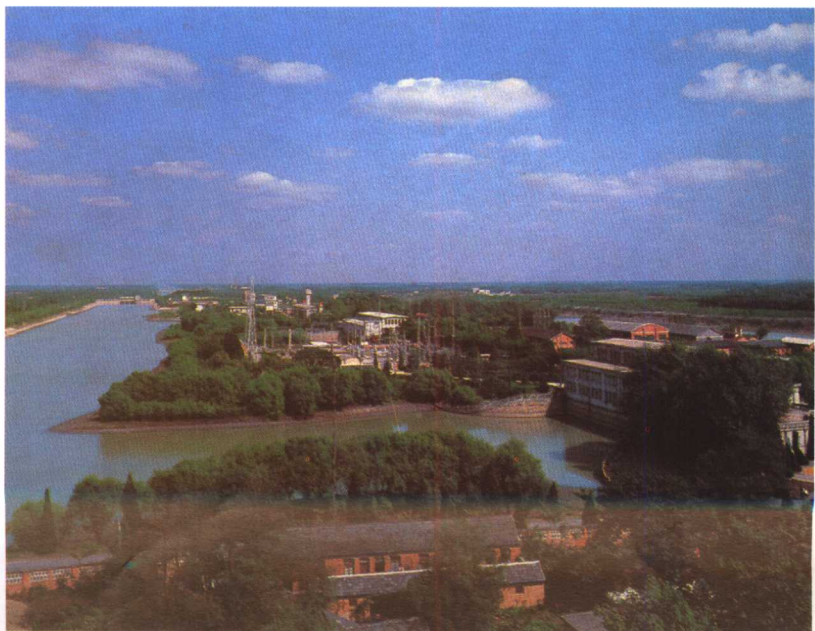
南水北调东线引江龙头工程——江都抽水站全景
