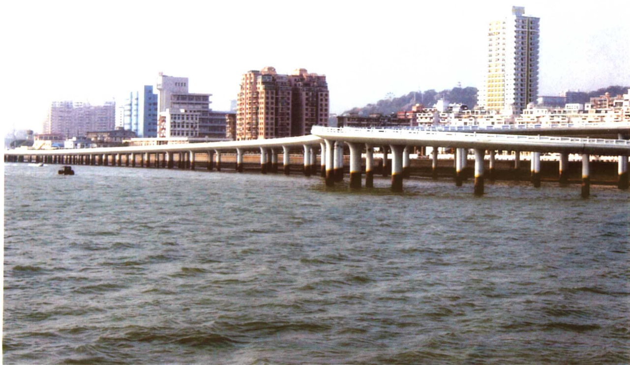
2003年9月7日，总投资5.6亿元、历时两年时间建设的厦门市环岛路海军码头至演武路段海湾桥正式通车。(林辉龙摄)
