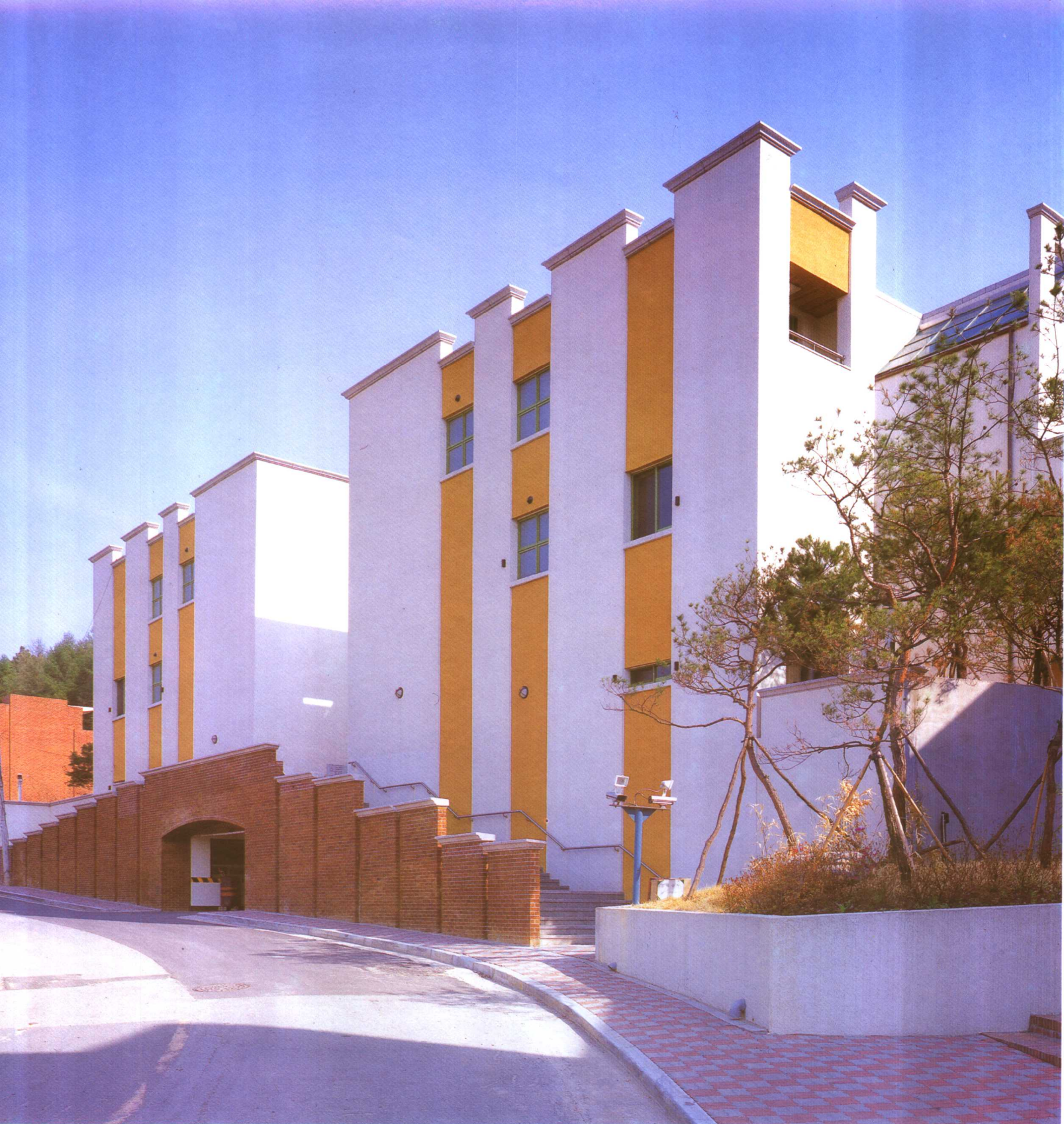
西北侧全景。正面部分好像一座高高的城墙，增加了内部的深邃感。
