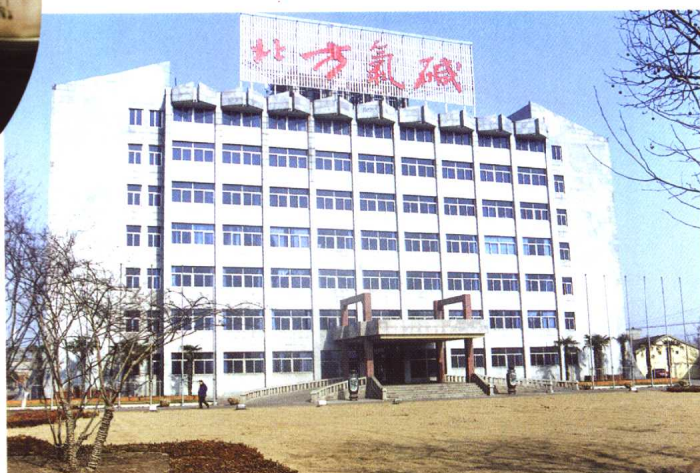
北方氯碱集团综合办公楼
