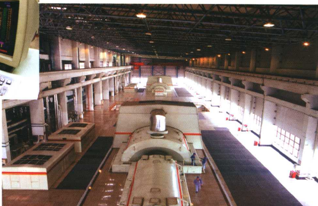
两台 30 万千瓦发电机组
