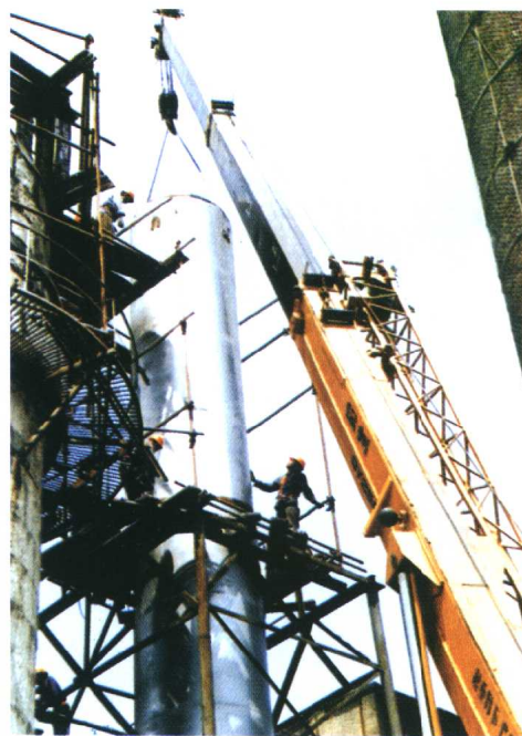
锅炉分场工人在检修除尘器
