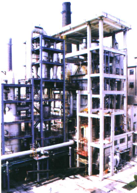
安全顺利建成我国首台 15 兆瓦 增压流化床联合循环中试电站
