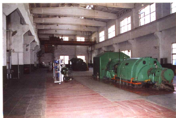
两台 6000 千瓦汽轮发电机机房
