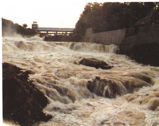
高崖水库溢洪闸
