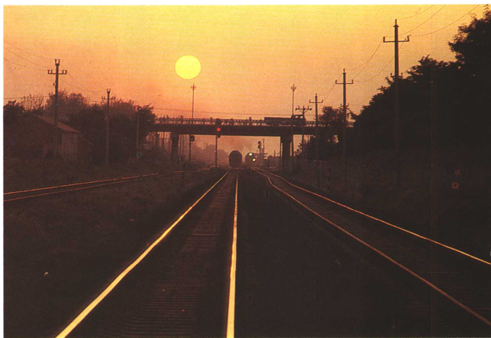
东环路立交桥
