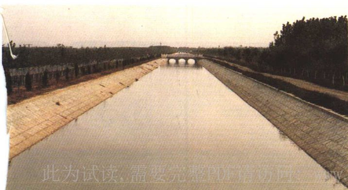
南水北调工程干渠
