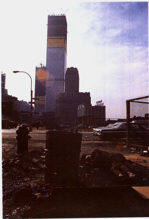
1970年正在建设的世贸中心双塔
