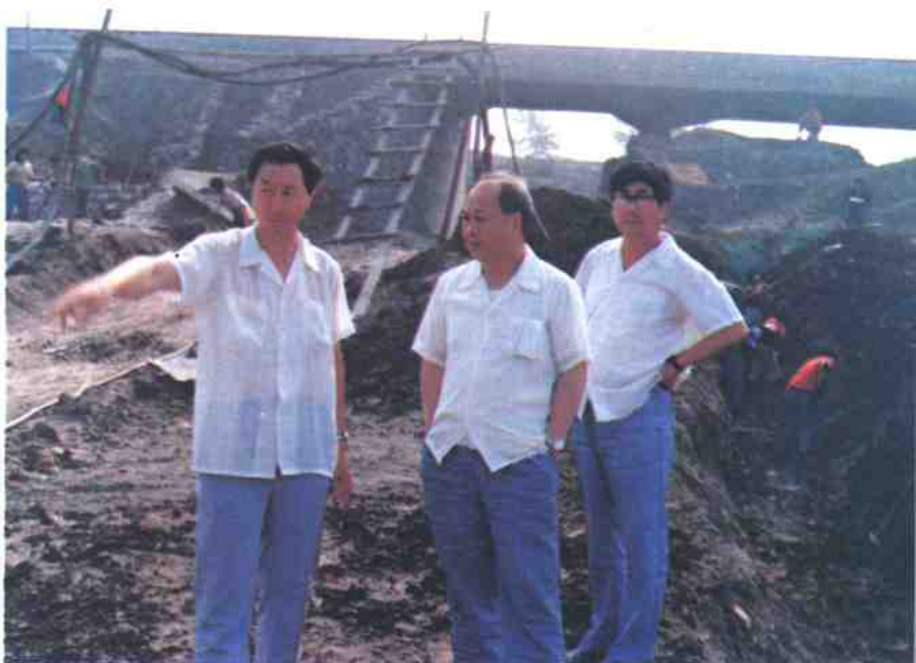
市政府领导检查北环路 立交桥工程（1988年）
