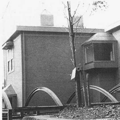
③ 住宅外观。汽车棚统一为H型钢的拱型构架
