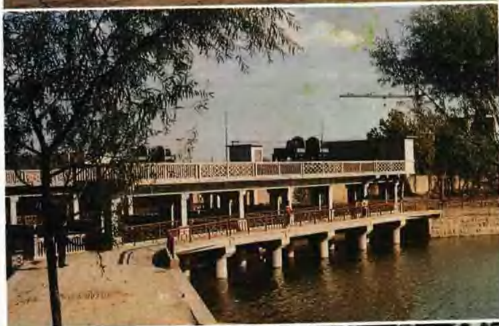
幸福河过青坡沟双闸（距水利局东北角50米）
