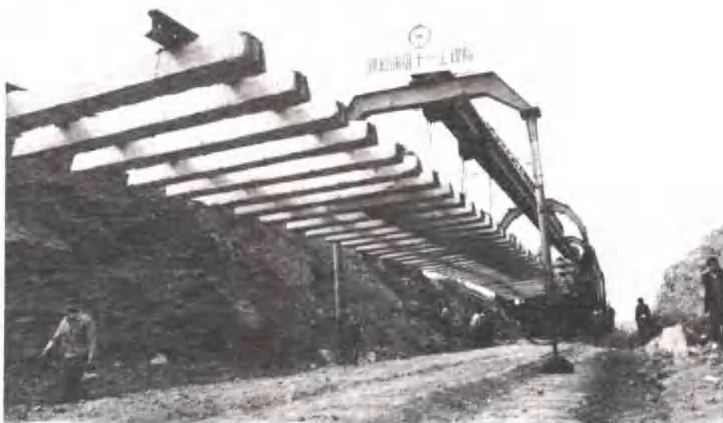
铺筑中的 桃威铁路
