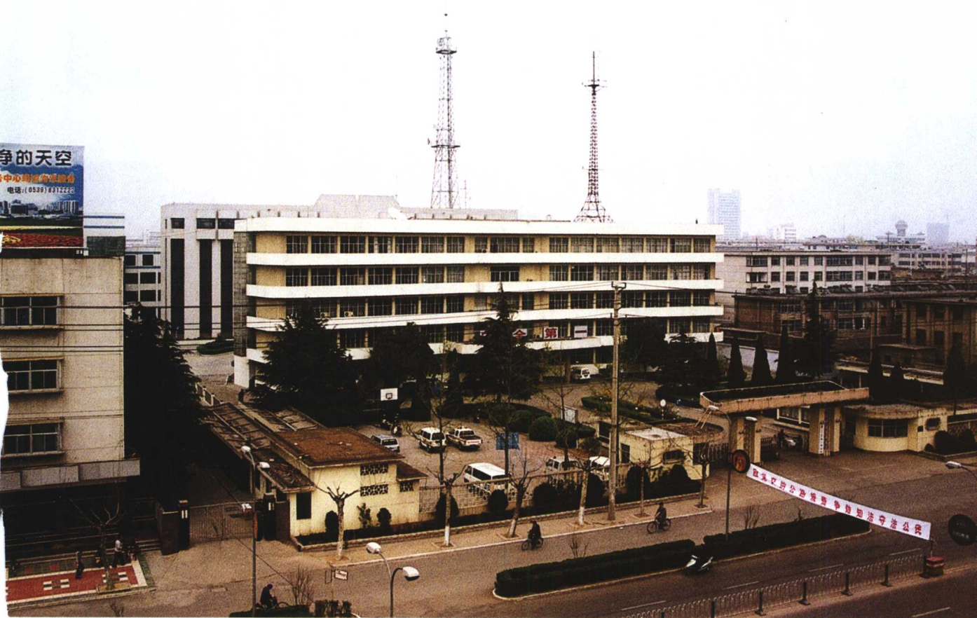
临沂电业局电力调度大楼
