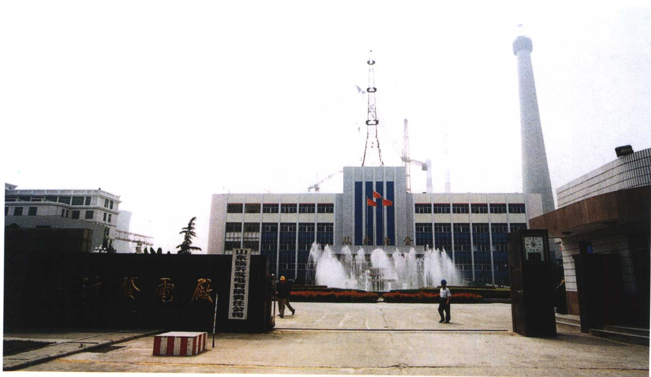
临沂市第一座大型火力发电厂——临沂发电厂
