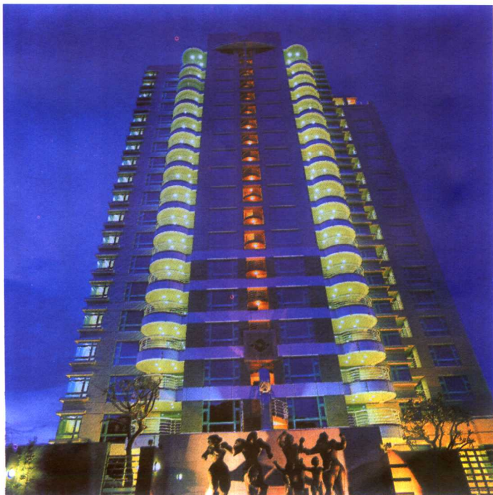
〔原山主人〕建筑外观
