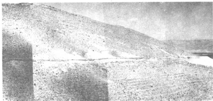
图2. 两千年前，涅杰夫沙漠的纳巴特居民，修筑这条渠横穿岗丘来汇集降雨径流。渠道把水引到图右方的窖里。远在图右方（已看不太清楚）有一条相似的渠道，将来自岗丘另一面的径流排走。
