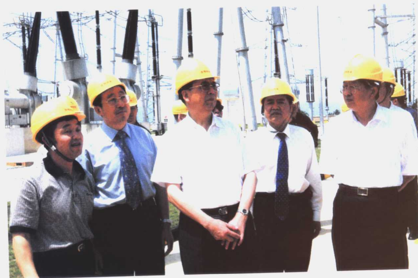
7. 2003年8月21日, 国务院副总理曾培炎视察云南宝峰变电站。
