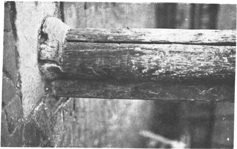
甲 蘇州某宅木槓及礎石
