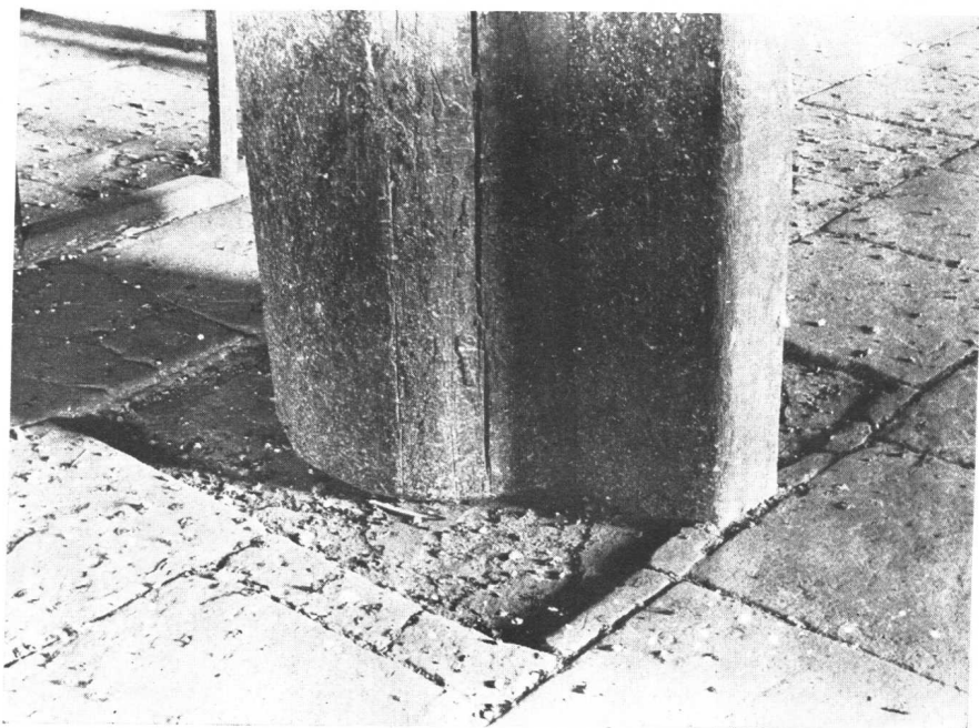
甲 大同善化寺大雄寶殿平柱礎
