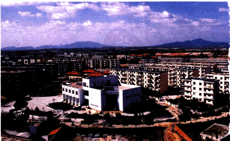
港务局第一生活区
