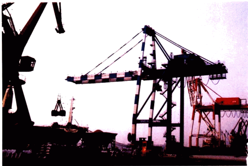
集装箱装卸桥
