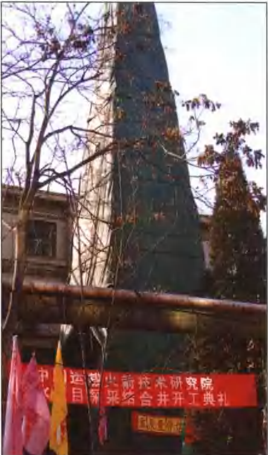
北京市地矿局承担中国运载火箭研究院改水项目施工现场
