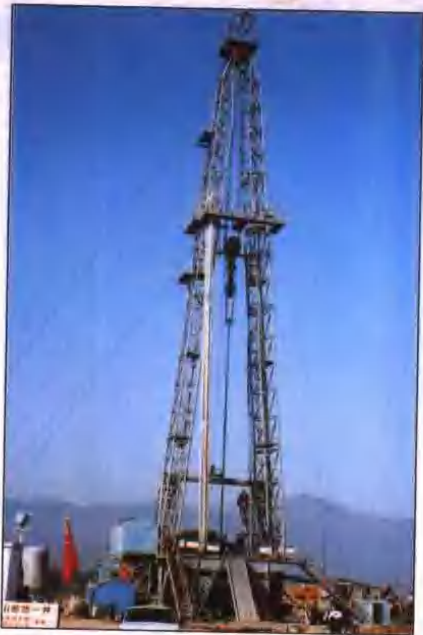
地热资源勘查与打井施工现场
