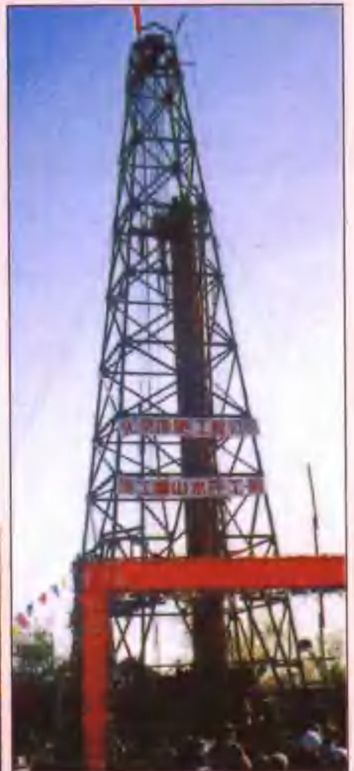
1998年10月，北京市地矿局 为香山地区打成一口日产水3000 吨的矿泉水井
