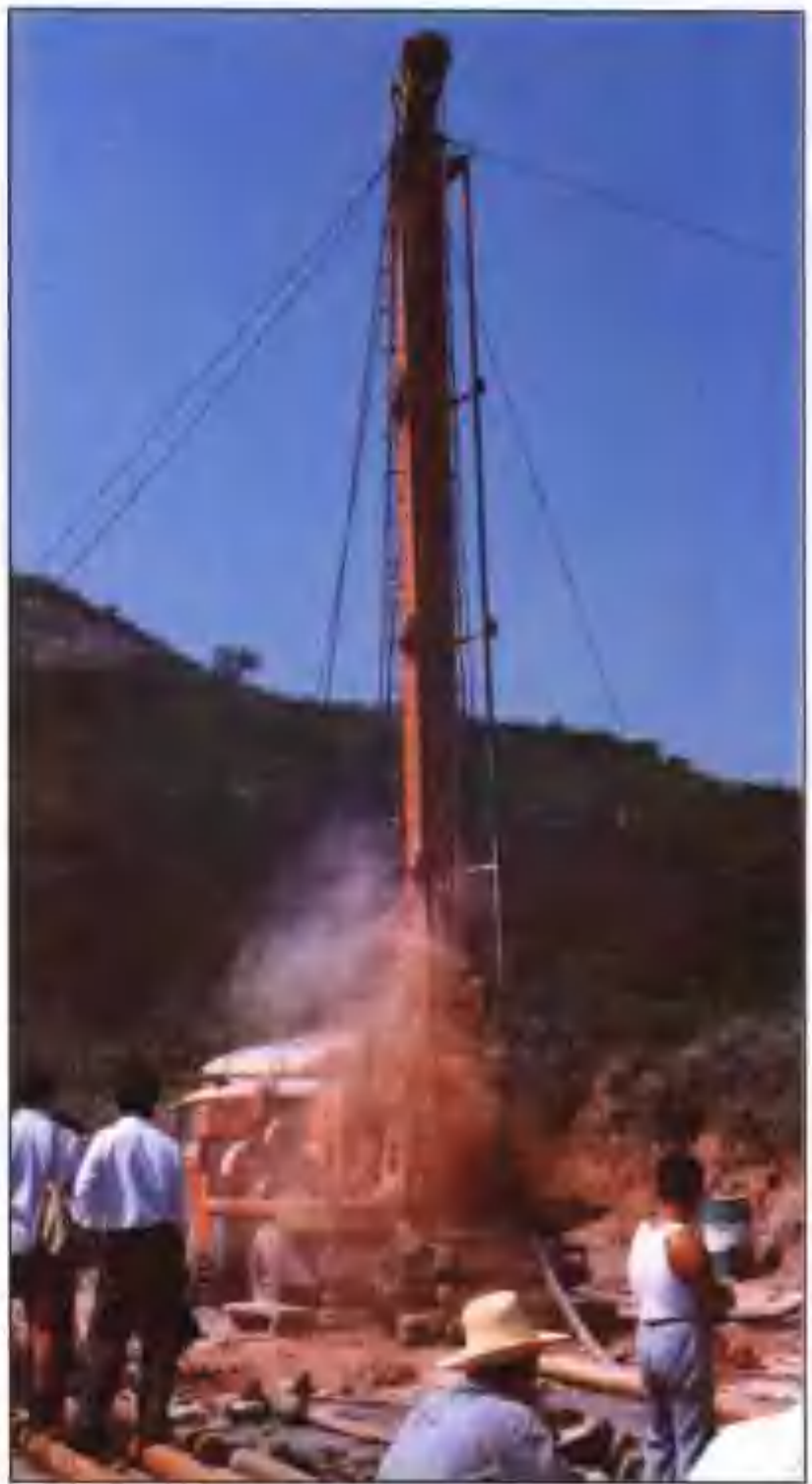
西山供水工程施工工地
