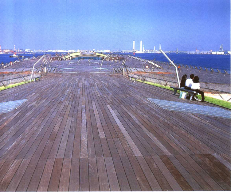
从木板通道看大桥方向
