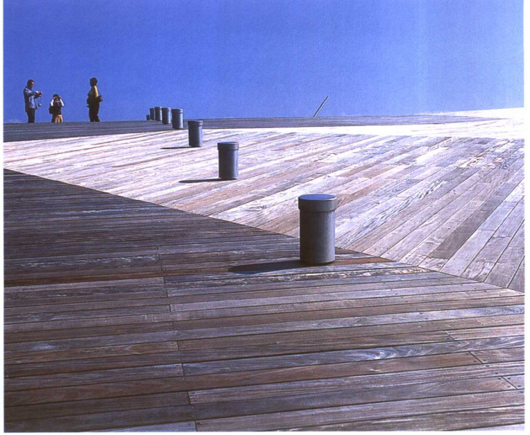
改变角度铺成的木板通道
