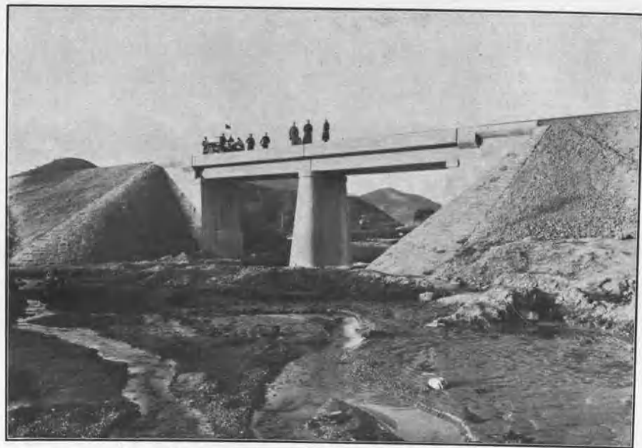
橋梁板土凝混筋鋼籐黃
