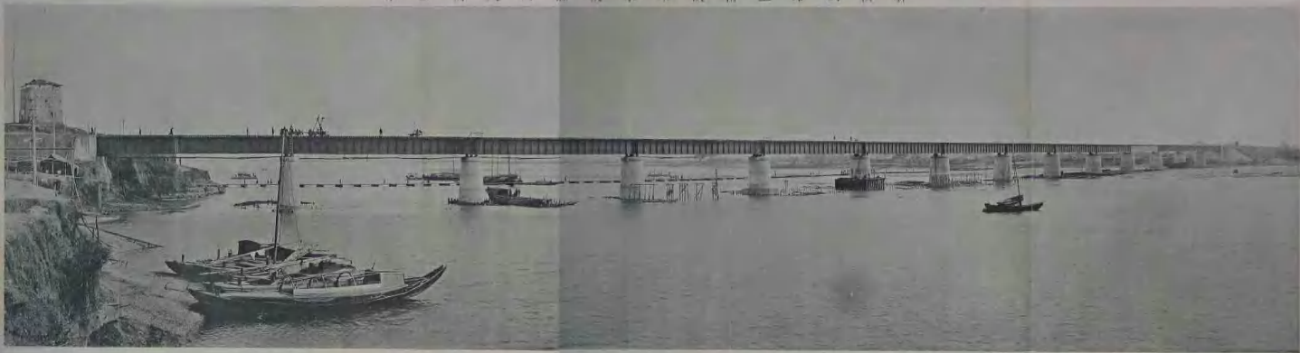
浙贛鐵路玉段梁家渡河大橋全景
