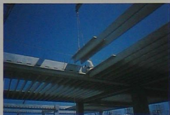
预制混凝土吊装工程
