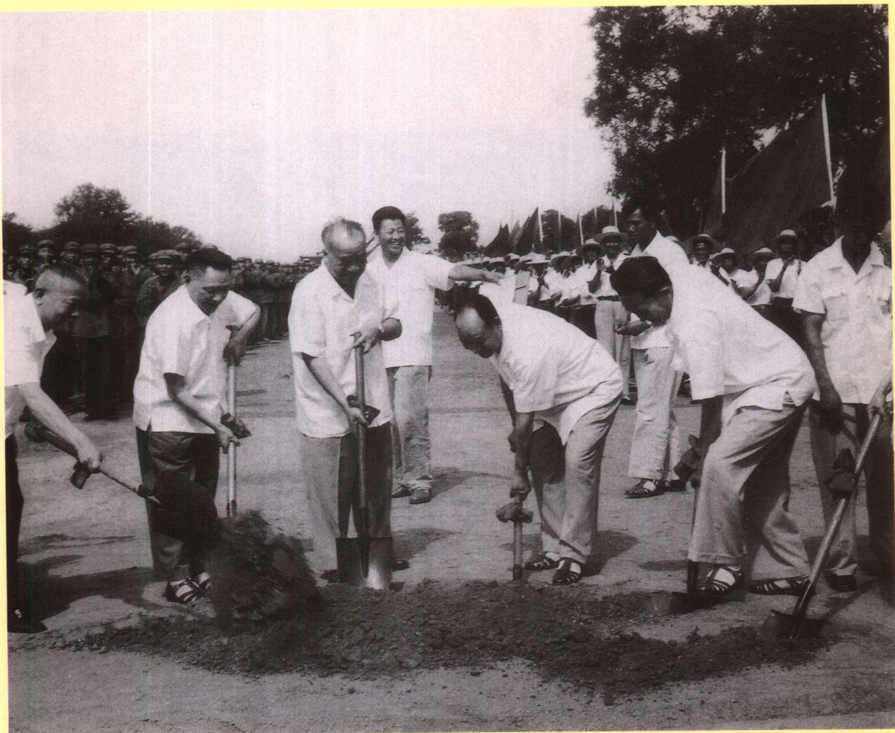
1965年7月1日，党和国家领导人朱德、邓小平、彭真、李先念等在为北京地铁一期工程奠基
