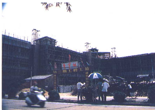
全国最大的电子碗柜生产基地——顺德杏坛镇 康宝电器厂第三期工程工地
