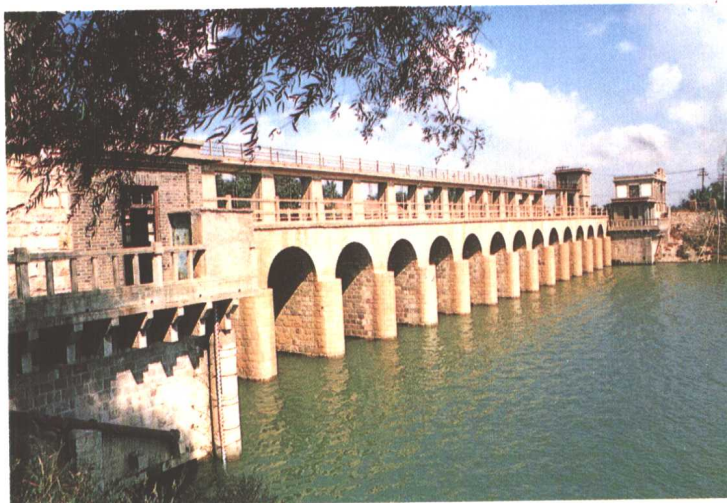
北王珠镇闸子提水站
