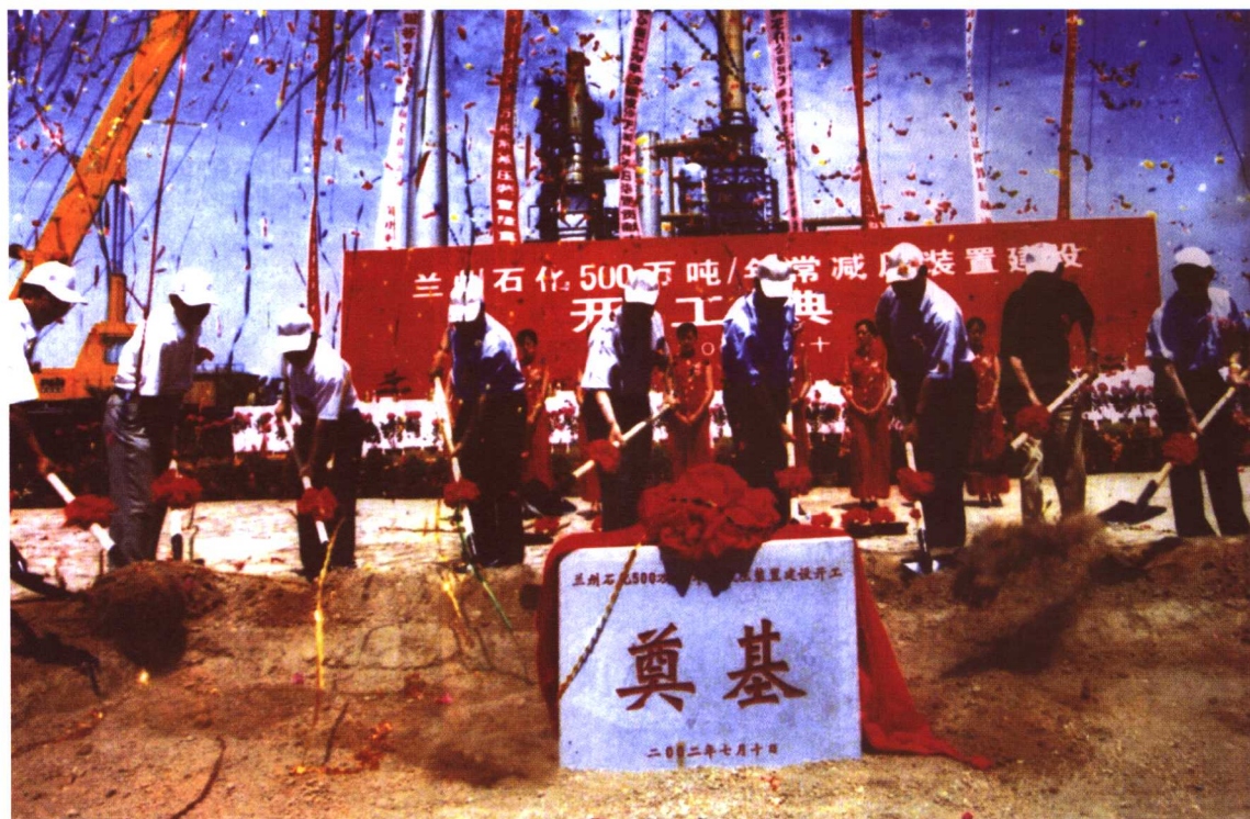
千万吨级炼厂“龙头”昂起——兰州石化 500 万吨 / 年常减压装置开工
