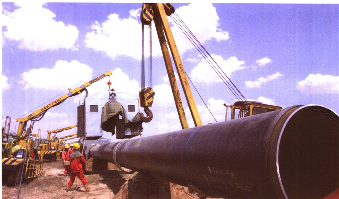
西气东输开工后，施工进度优质快速
