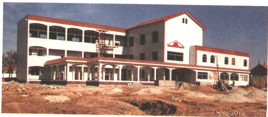
即将竣工的鸿阳石英砂有限公司办公楼
