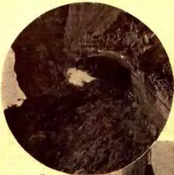
◇ 在寶成鐵路北段秦嶺山中穿鑿了許多隧道。
