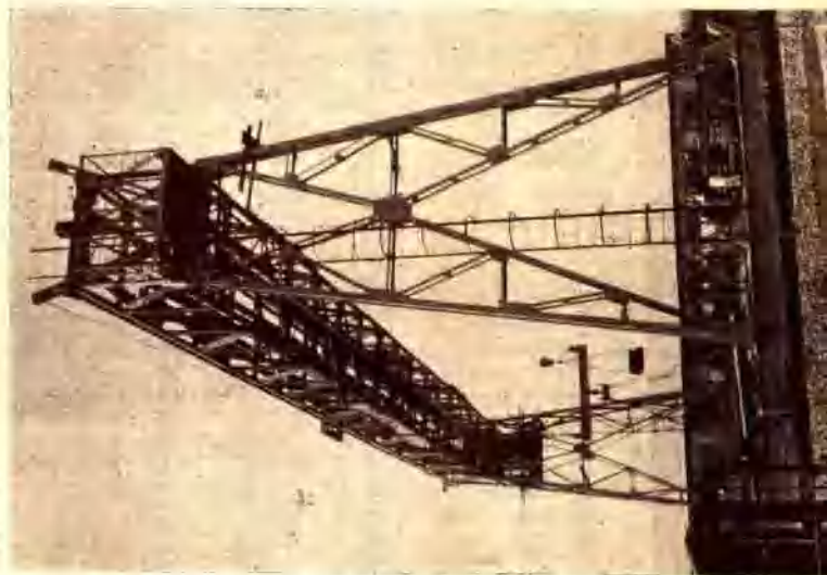
△ 這是中國首次製成的衝擊式大型鑽機。建築長江大橋的工人們用這台機器衝擊江底岩層。
