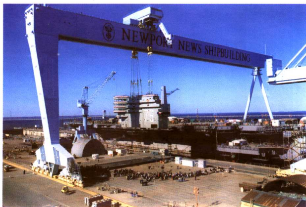
正在安装舰桥的 CVN-76 “罗纳德·里根”号是尼米兹级的 9 号舰
