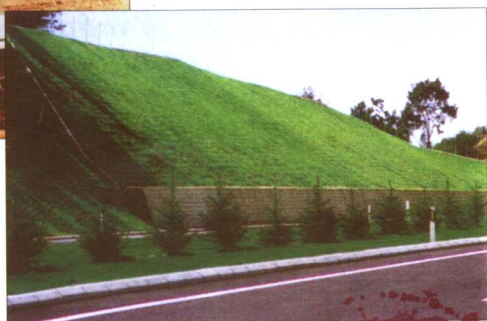
喷播机护坡喷播施工 现场及喷播成坪草坪
